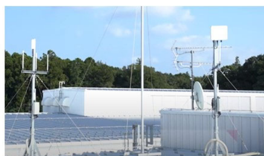
屋外施設 (Wi-Fi4/5のアクセスポイントとIoT用LoRaアンテナ)
