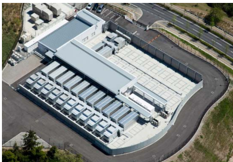
データセンターパーク外観
