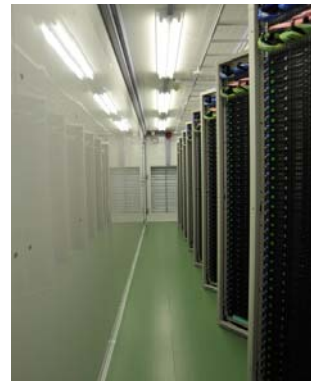
IZmo 内部の作業空間
