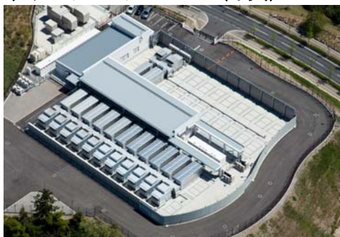
データセンターパーク外観
