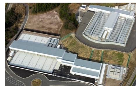
松江データセンターパーク開設(2011年)
